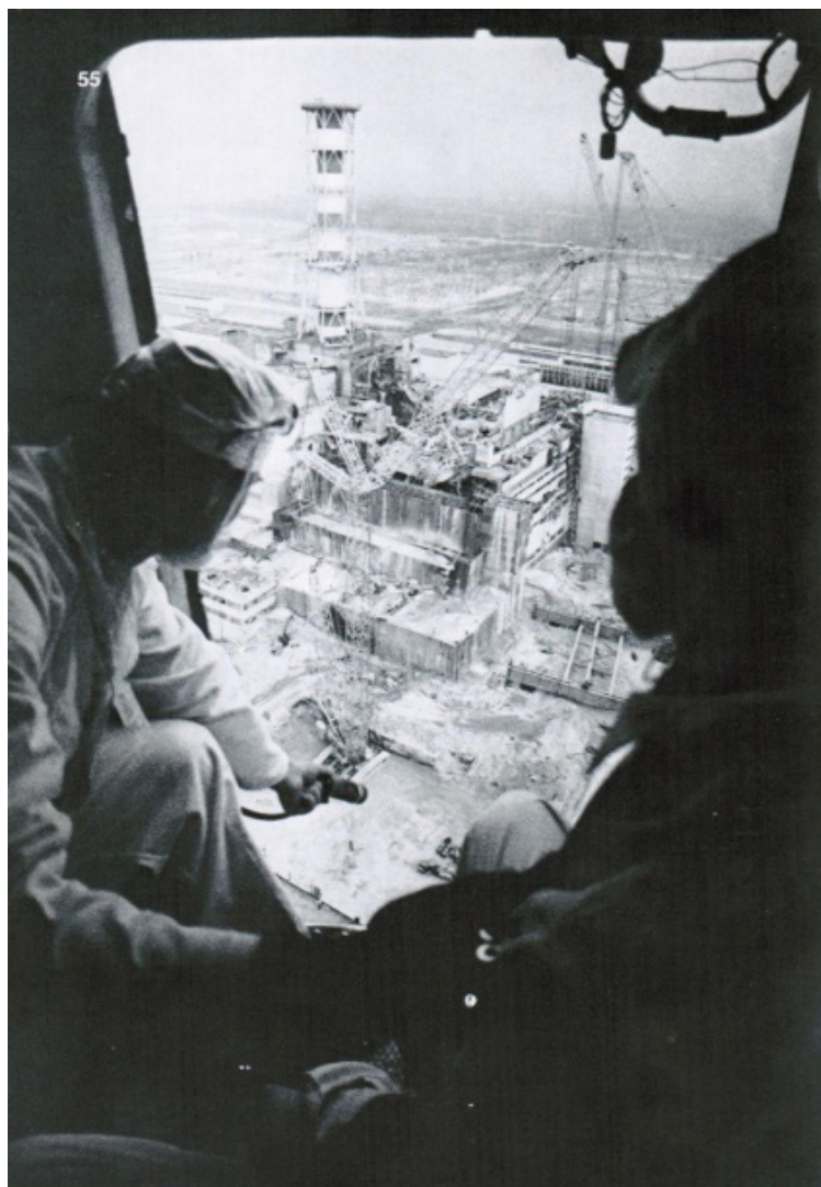
А.В. Симаков (слева) измеряет мощность дозы гамма-излучения над энергоблоком ЧАЭС. Сентябрь, 1986 год
