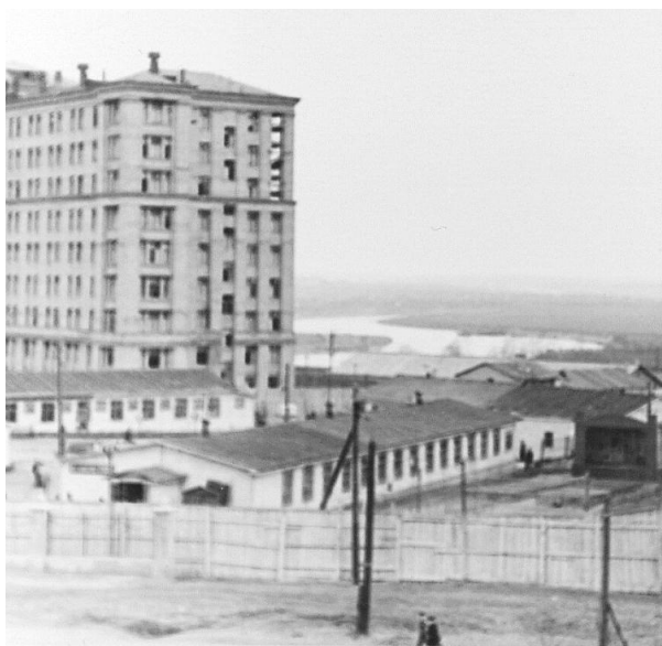
Строительство больницы № 6. 1958–1960 годы
