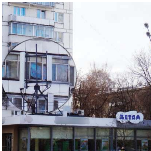
Рис. 6. Расположение БС на уровне окон жилого дома на расстоянии нескольких десятков метров
